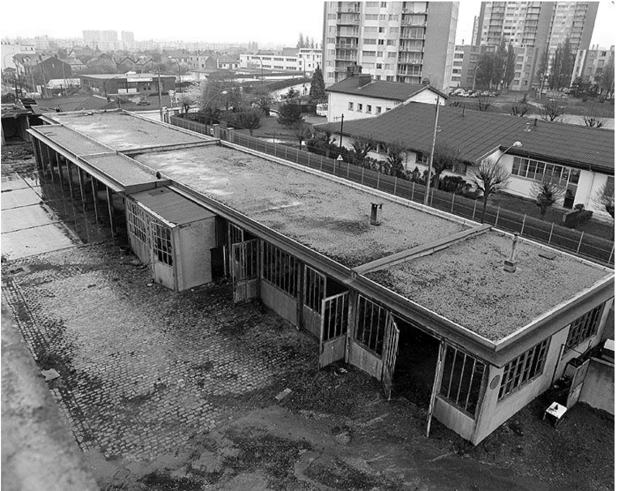
Bâtiments divers de service à l'est de la cour. Campagne photographique, lors de la destruction du bâtiment en 1976.
