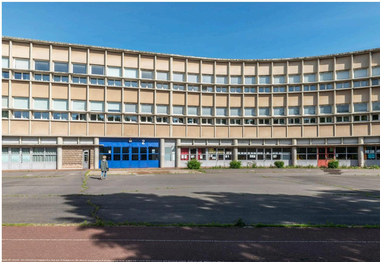
Détail des élévations de l'aile des filles, avec la trame d'1,80 m mise au point par l'architecte Jean-Pierre Paquet.
