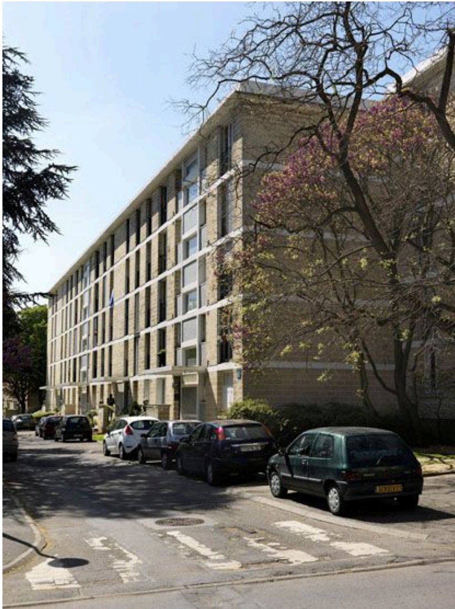
Vue générale de la barre J.
