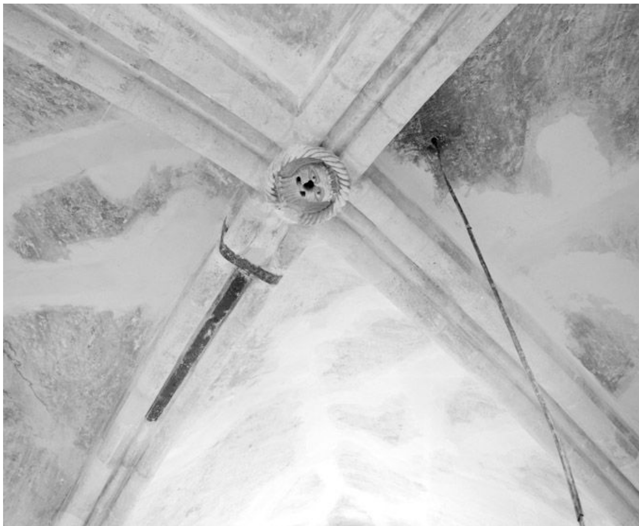
Voûte de la nef, vue depuis un échaffaudage en 2005. L'ogive a été confortée par un élément métallique.
