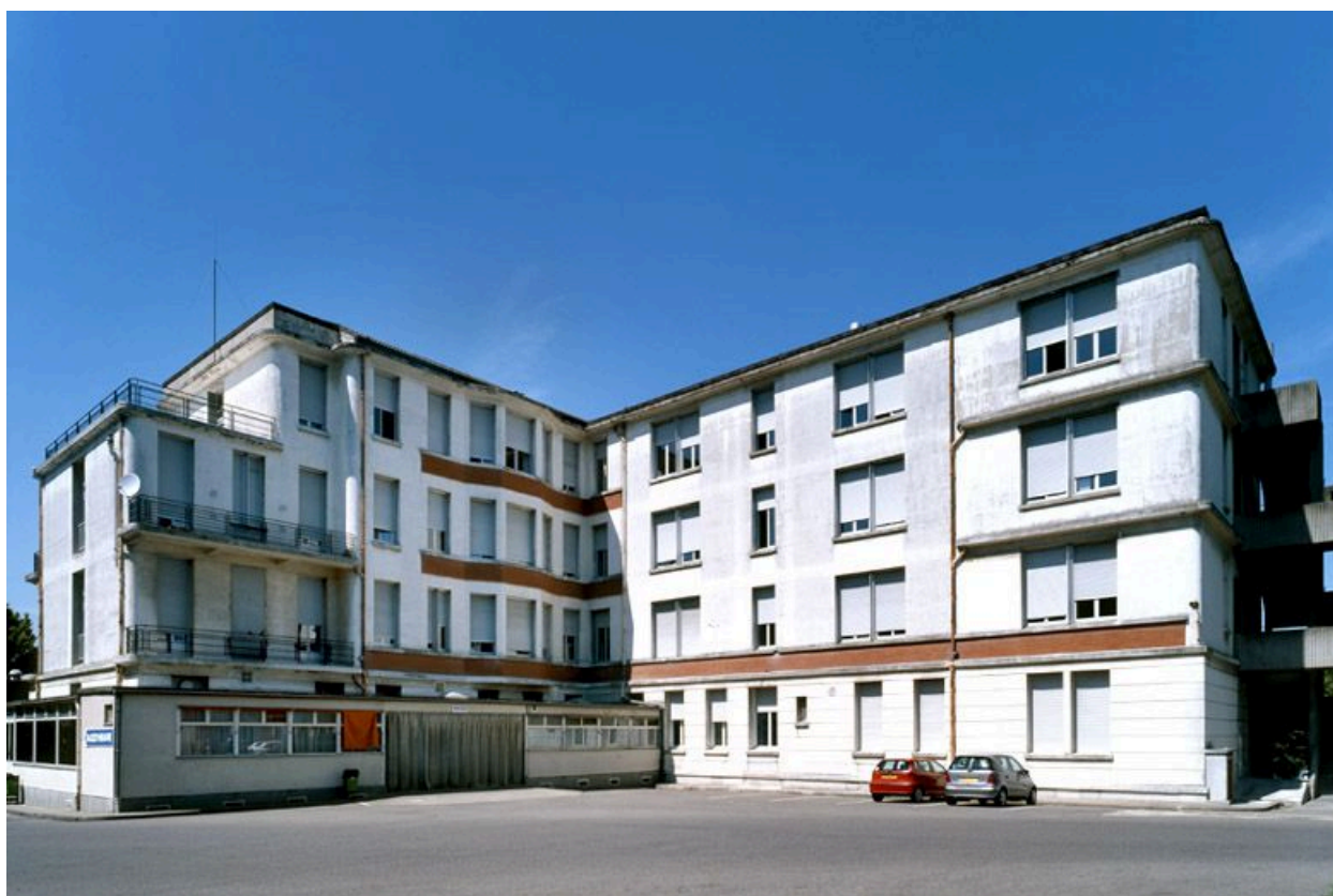
Bâtiment des années 1960.
