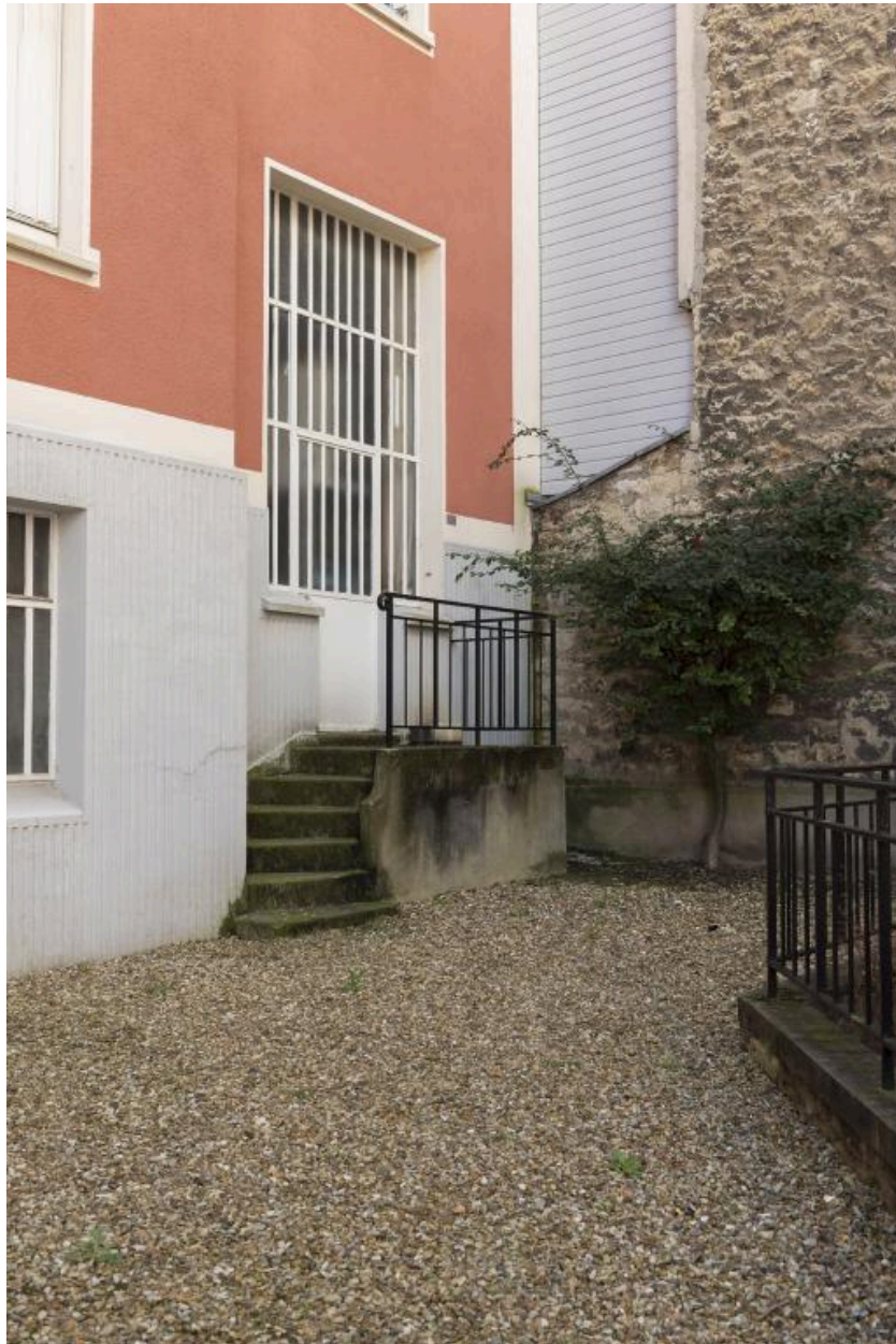
Vue des ateliers situés au rez-de-chaussée (4)
