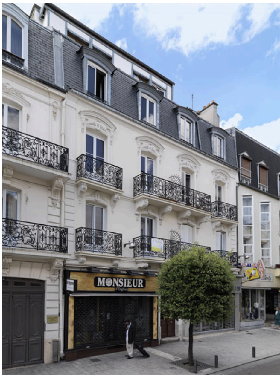
Vue d'ensemble de l'immeuble, 60 rue du Général de Gaulle.
