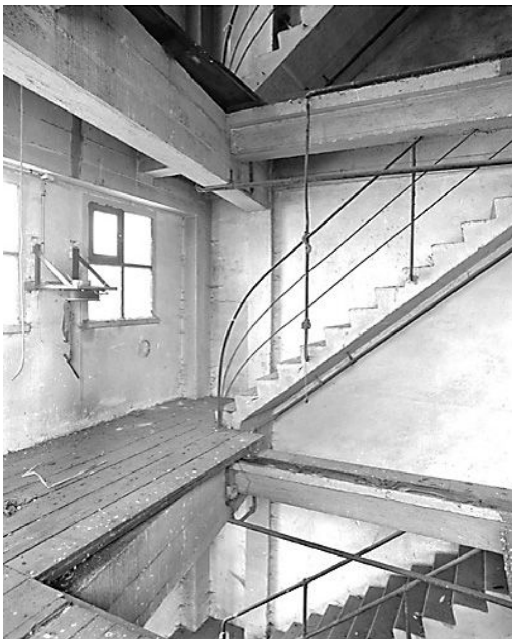
Partie avant-nettoyage. Escalier, au sud-ouest de la minoterie. Vue prise depuis le 2e étage.
