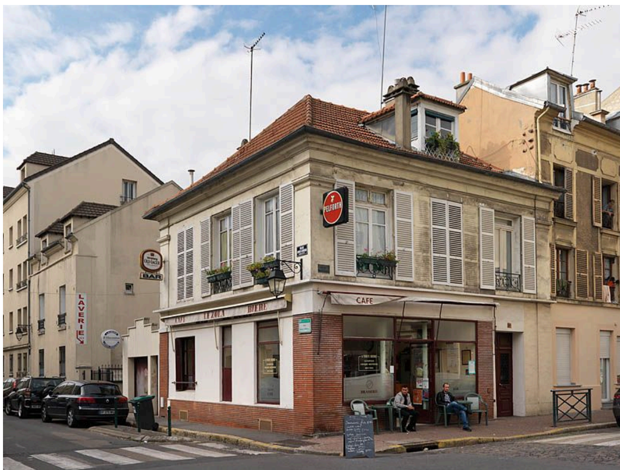
Choisy-le-Roi, maison, rue Emile Zola, 22 bis rue Georges Clémenceau. Elévation antérieure.
