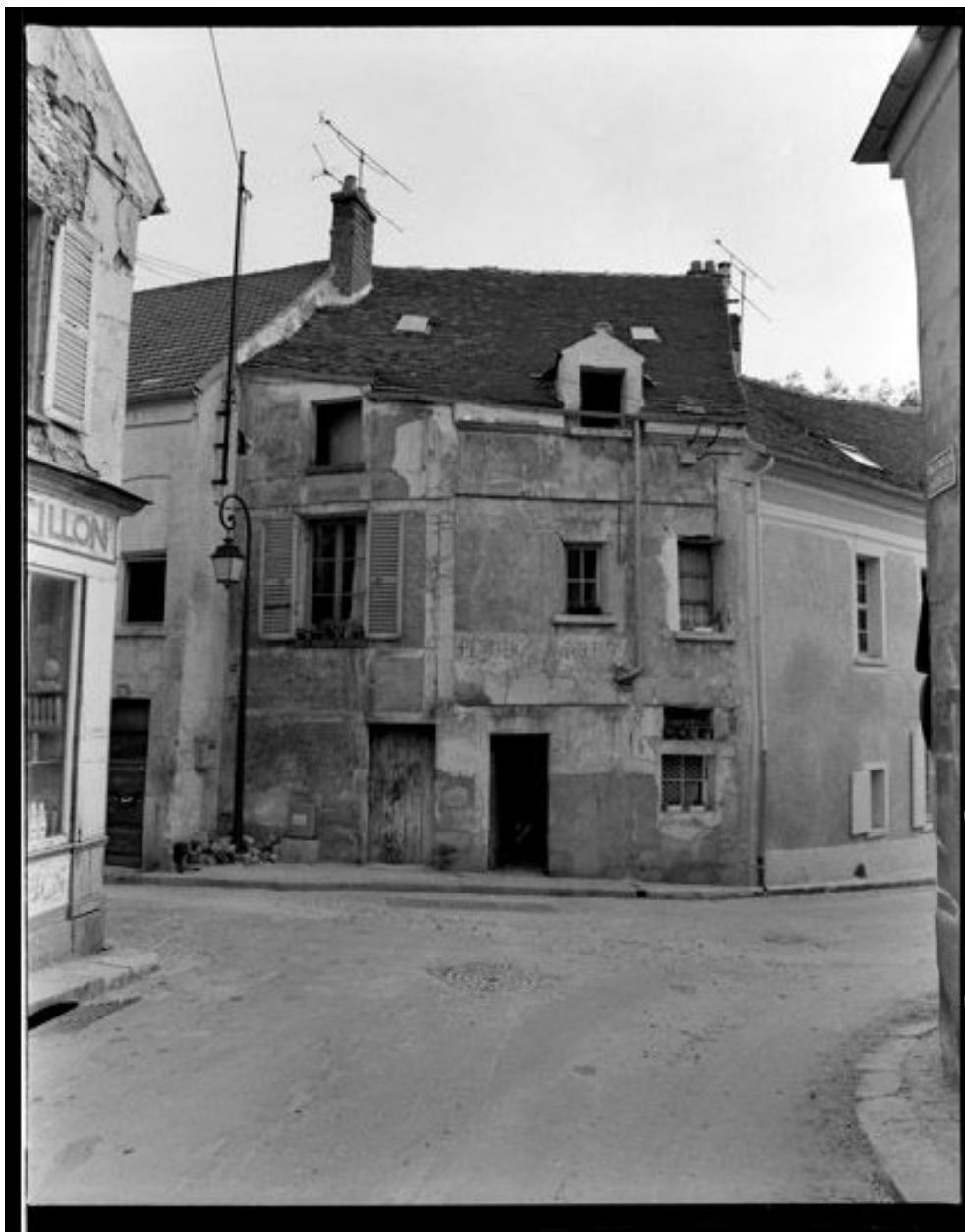
Maison, Tanneries (rue des) 2. Vue de la façade sur rue.
