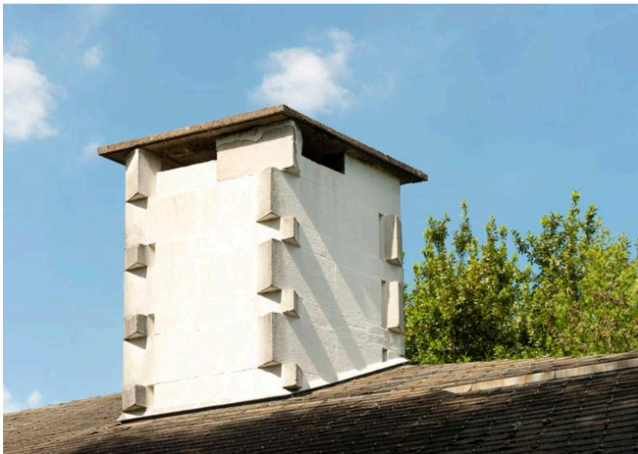
Vue de la cheminée.
