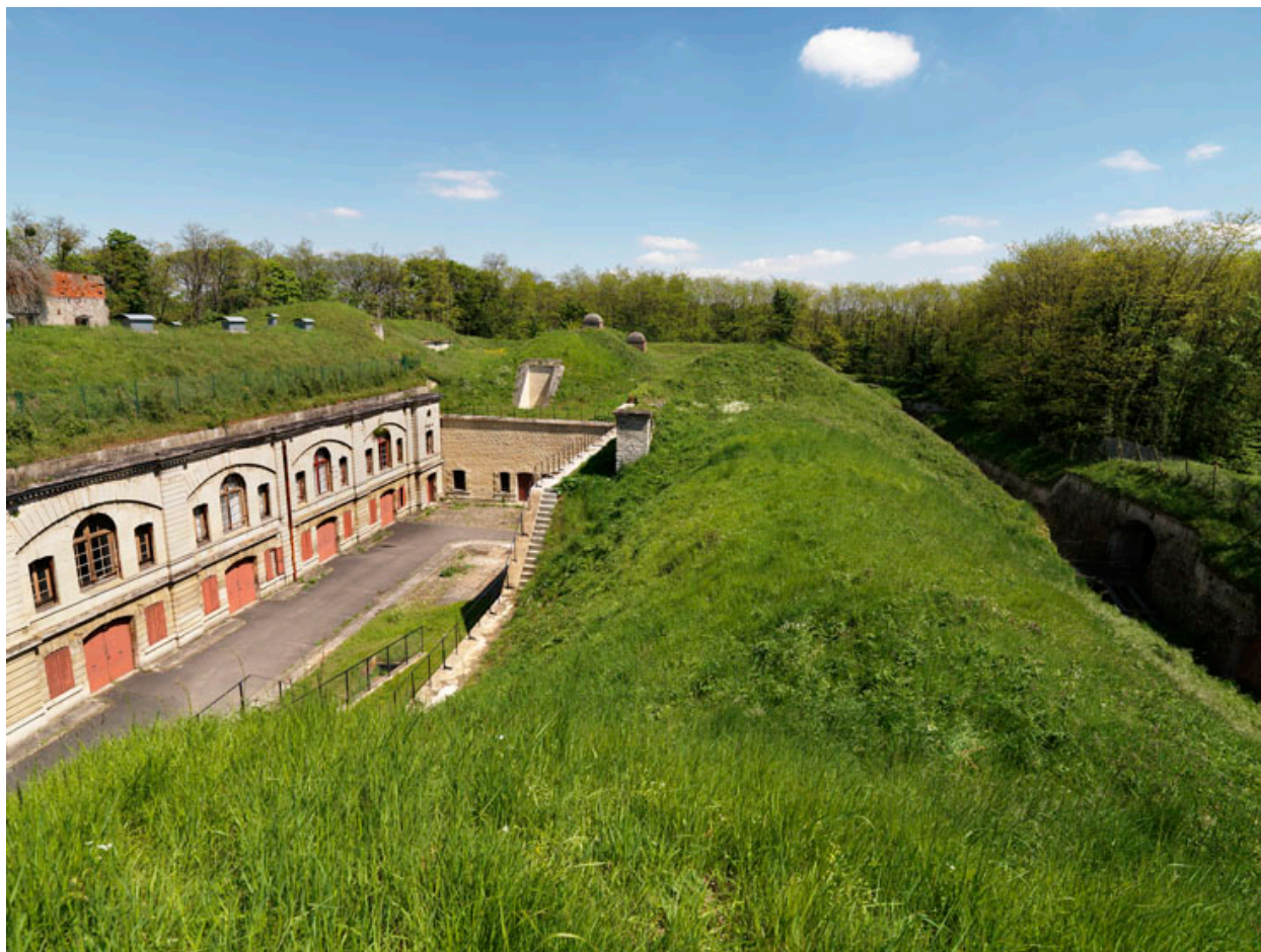
Vue de la couverture engazonnée du rempart, avec à gauche, le bâtiment de la caserne, et à droite, le fossé d'entrée.
