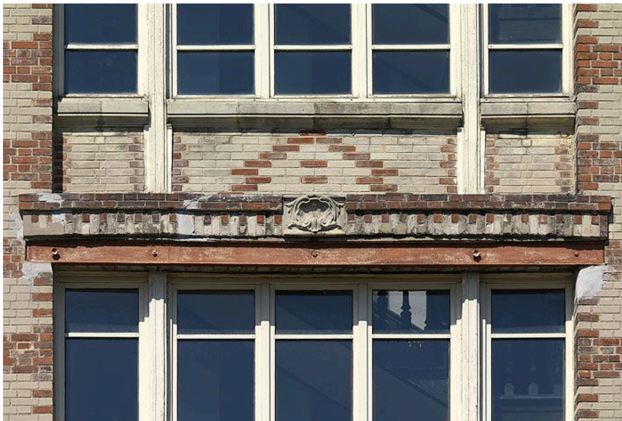
93, Courneuve (La), usine de construction mécanique Mecano, 33 avenue Victor-Hugo. Détail de la façade de l'immeuble du bâtiment administratif.
