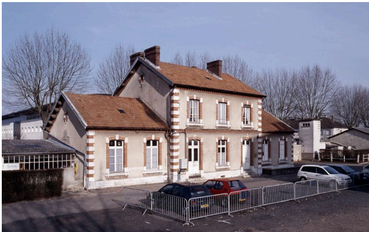
La caserne Augereau : petit bâtiment au nord du corps principal, bordant la rue Emile Leclerc.
