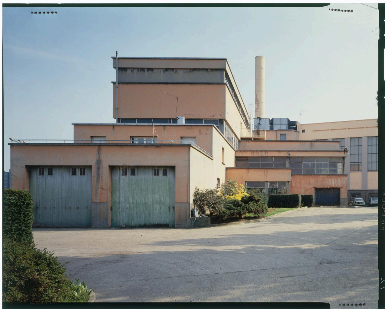
Vue de la façade postérieure. A gauche : l'aile de l'usine.
