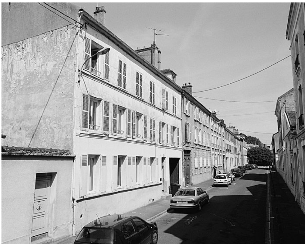
Vue générale de l'alignement d'immeubles rue Louviot, côté impair.
