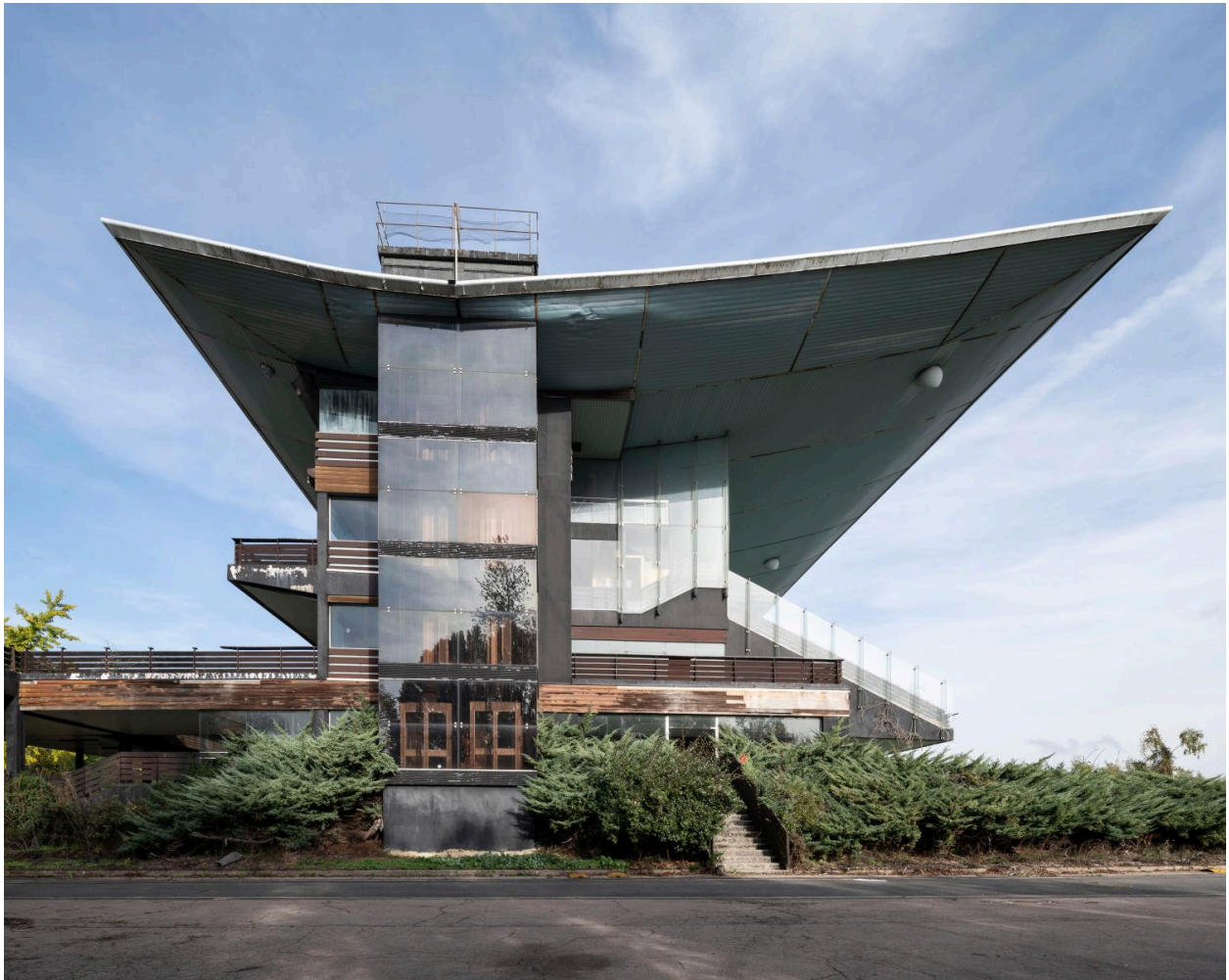
Vue latérale de la tribune et de son porte-à-faux à la forme effilée.
