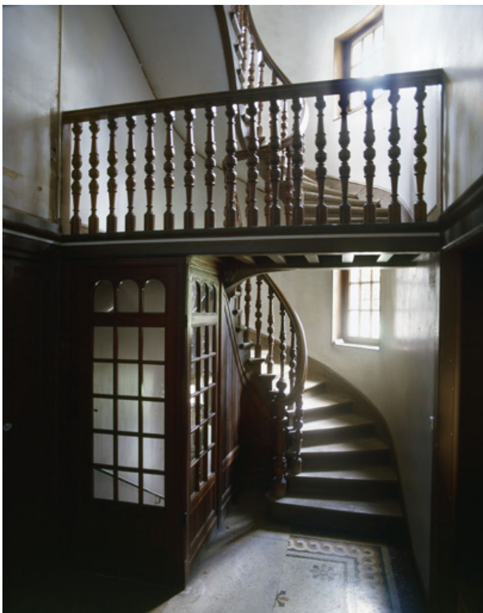
Villa Kermina : l'escalier de service occupant le volume intérieur de la tourelle hors-oeuvre située contre la façade posérieure.
