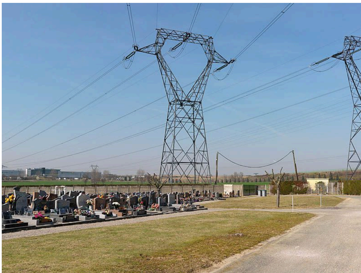
93, Tremblay-en-France, chemin des chemin des Platrières. Cimetière communal.
