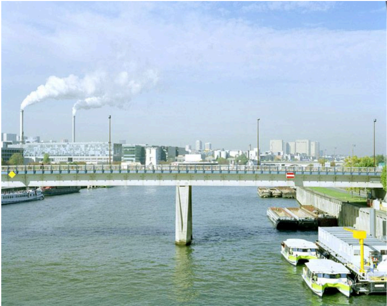
Ivry-sur-Seine, Charenton-le-Pont. Pont Nelson-Mandela. Vue d'une des deux tabliers.
