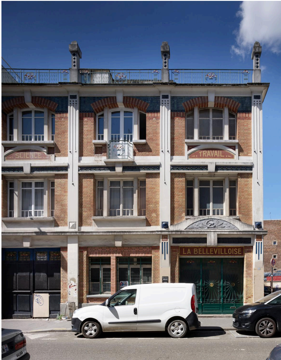
Vue générale du bâtiment, façade
