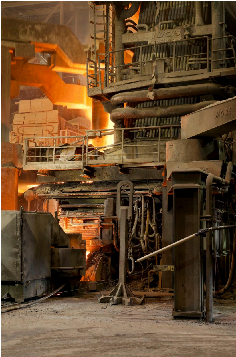
Halle du four, four à arc électrique. (réf. Département Seine-et-Marne : IVD77_2013_77_00238_NUCA)
