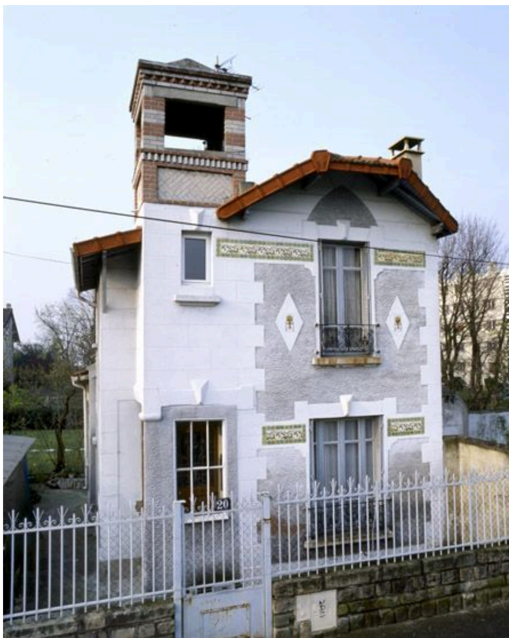
Maison, Chemin d' Exploitation. Vue d'ensemble de la maison et de son petit belvédère.
