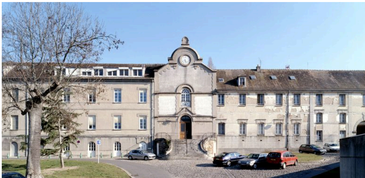
Façade du corps de bâtiment ancien (couvent des Récollets et ses prolongements).
