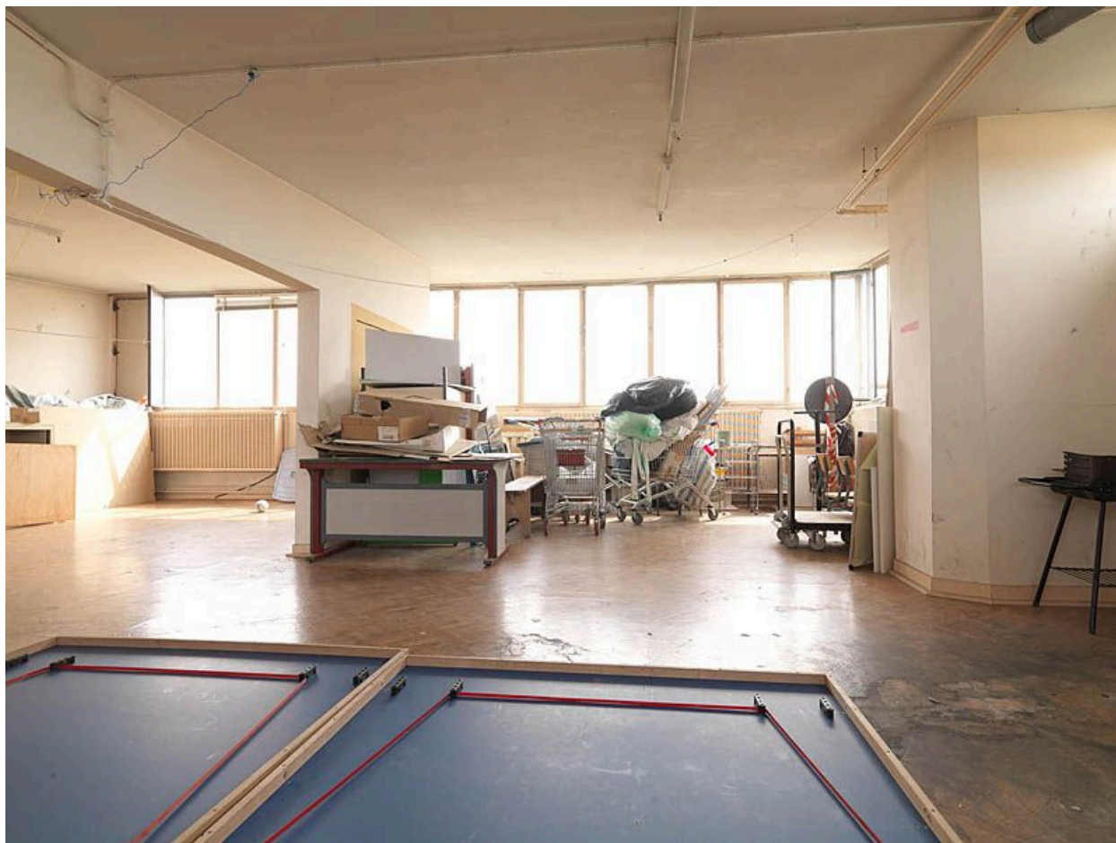
L'immeuble prototype. Vue intérieure des anciens séchoirs.
