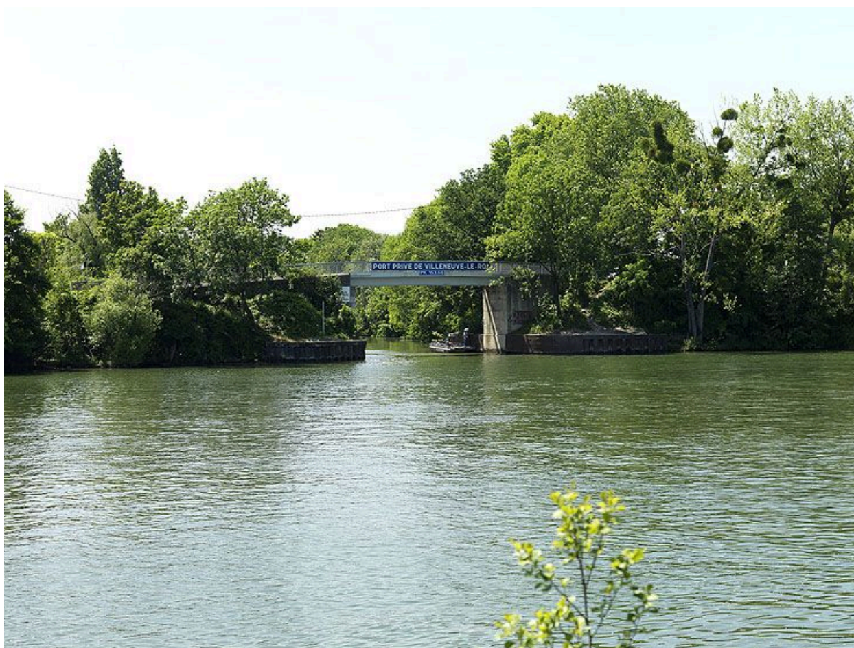
Entrée dans la darse de Villeneuve-le-Roi, vue depuis le quai de Villeneuve-Saint-Georges.
