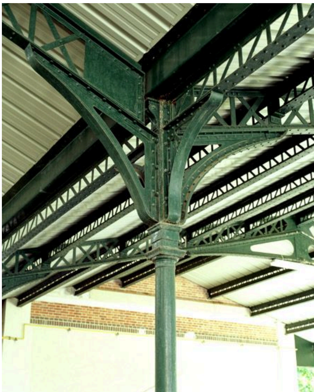
Détail de la charpente métallique du préau.
