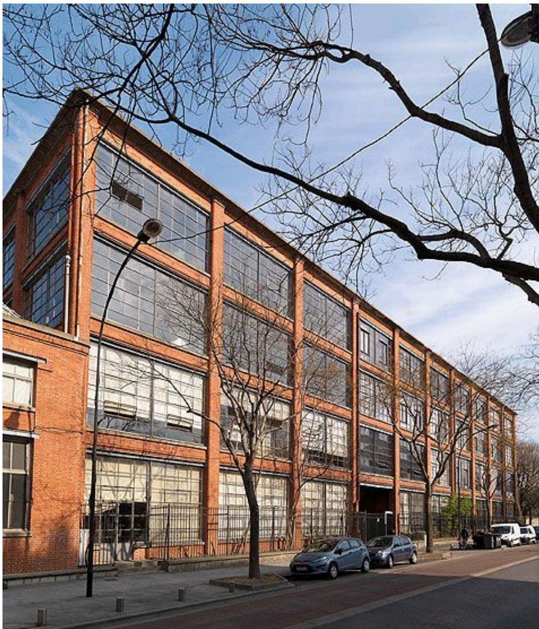
94, Ivry-sur-Seine, usine United Shoe Machinery Company, 27-29 rue Raspail . Elévation générale de la façade sur la rue.
