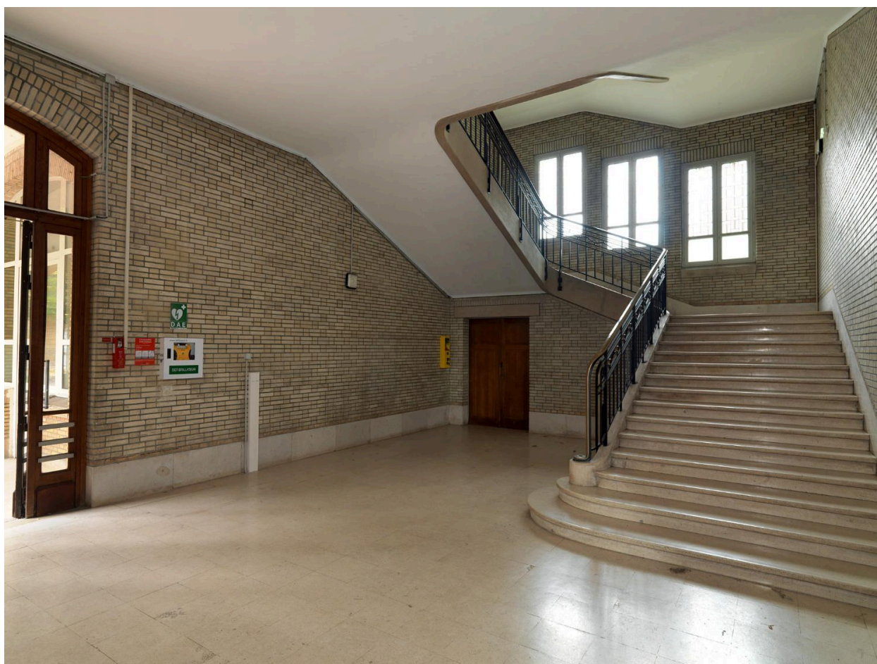
Détail du départ d'un escalier menant aux salles de classes.
