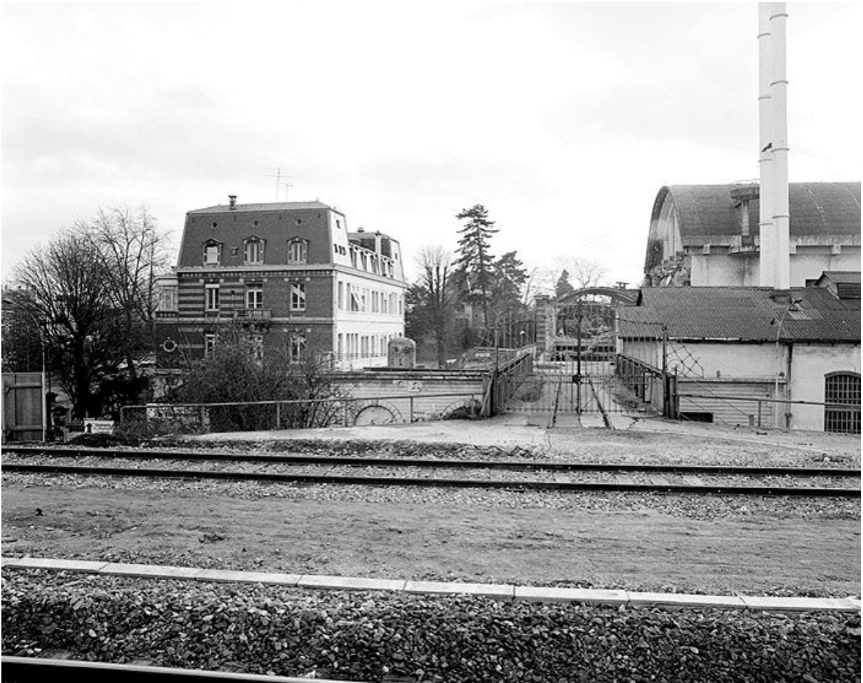
Vue d'ensemble, depuis la voie ferrée au nord : partie est de la brasserie Gruber (passerelle ferroviaire et bureaux). Photographie avant destruction, 1989. (Ministère de la culture, Inventaire général. 89SG689X)
