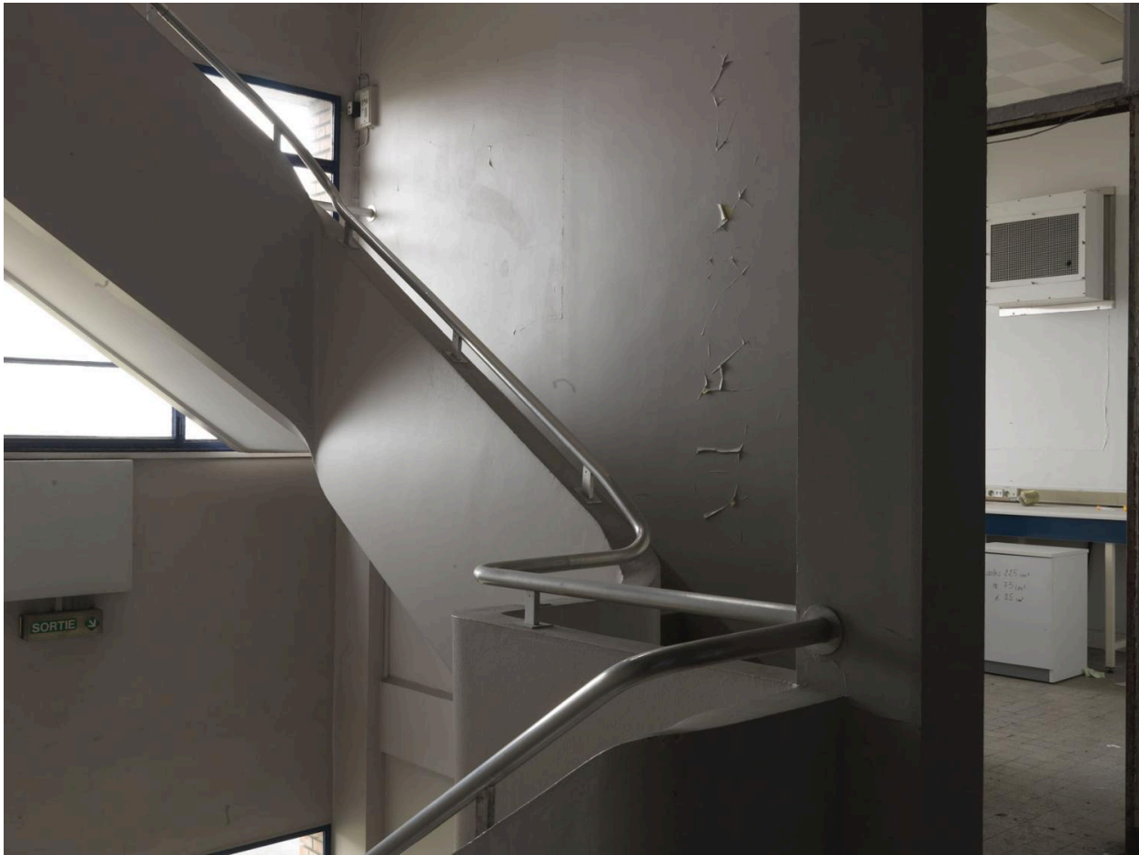
Site Sanofi. Escalier du bâtiment Nocard.
