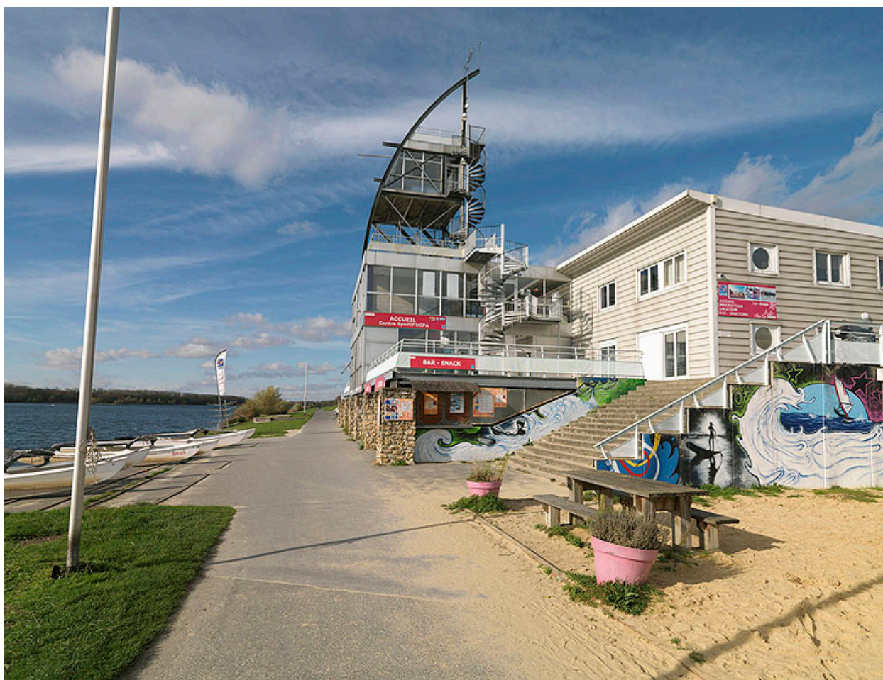
Le bâtiment de l'UCPA et la tour d'arrivée, vus de l'est.
