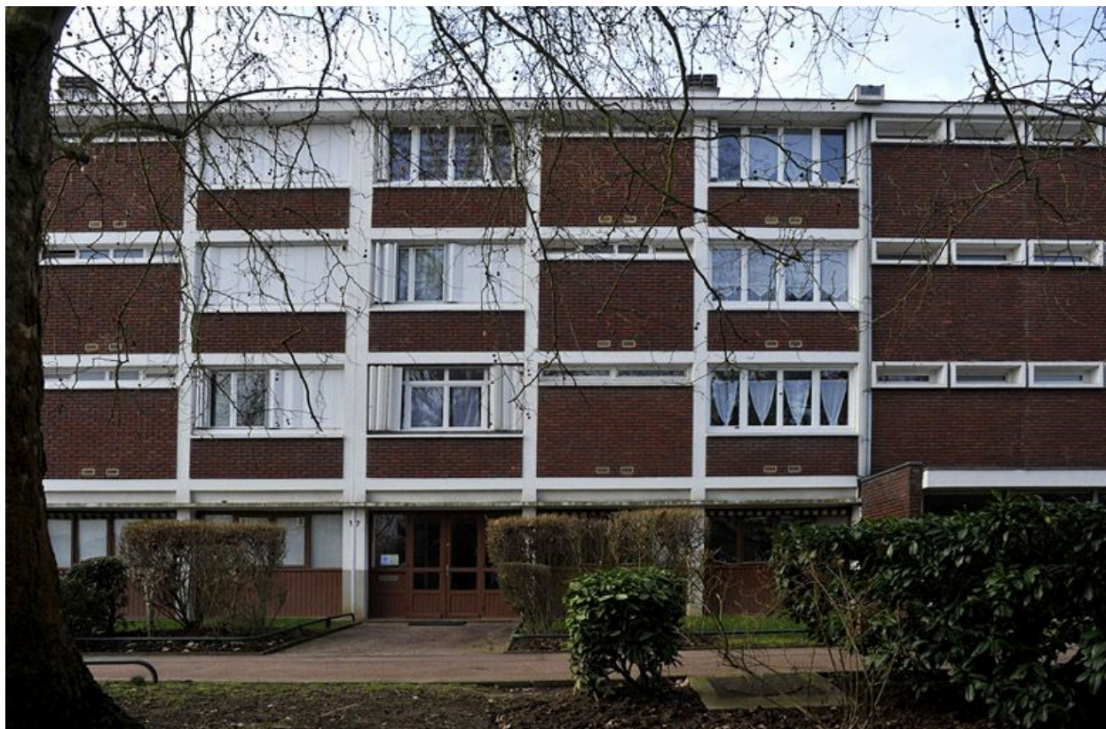
Verneuil-sur-Seine : le lotissement du Parc noir. Façade arrière d'une barre.
