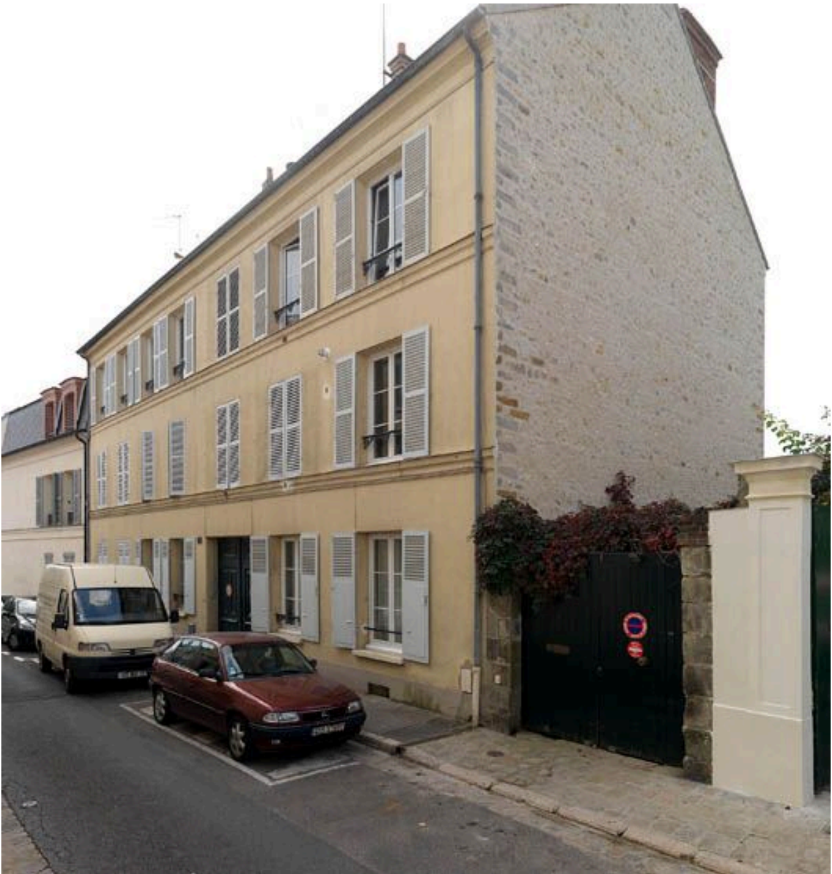
Ancien hôtel occupant le front de parcelle de la menuiserie.
