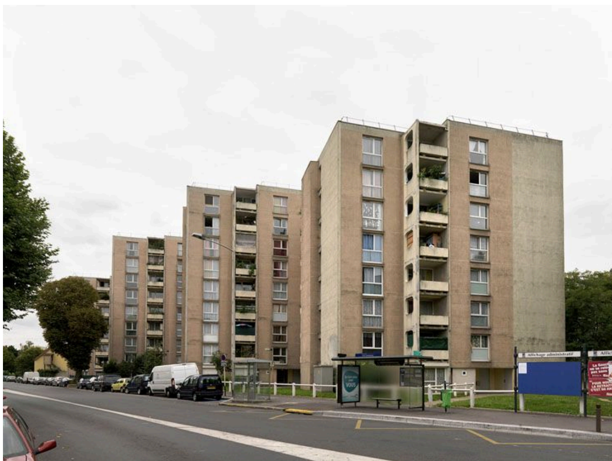
Cité Charles De Gaulle. Vue depuis l'avenue P. Kérautret.
