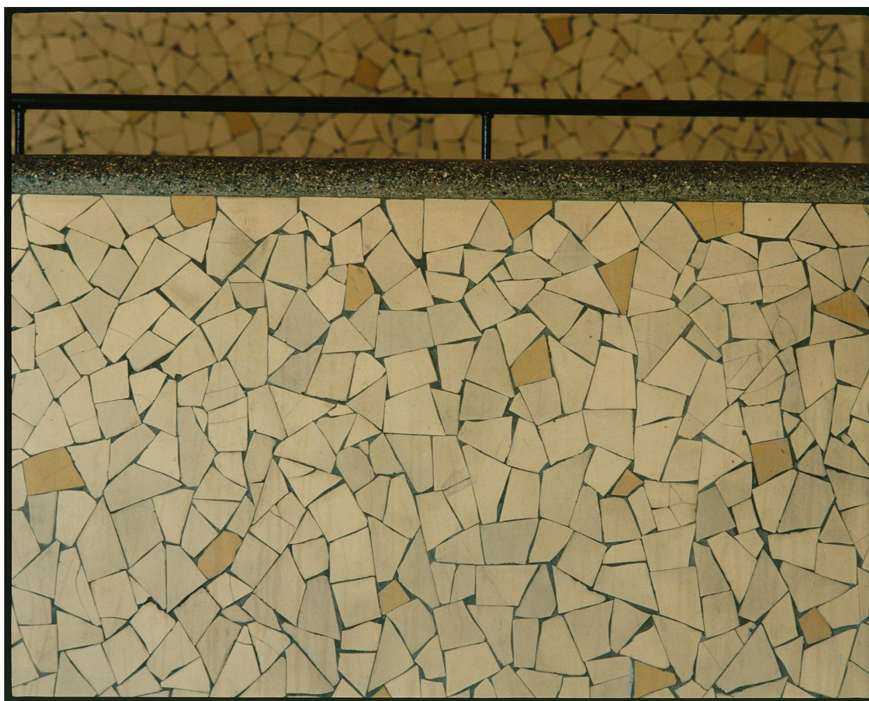
Escalier des déshabillloirs. Détail de la rambarde.
