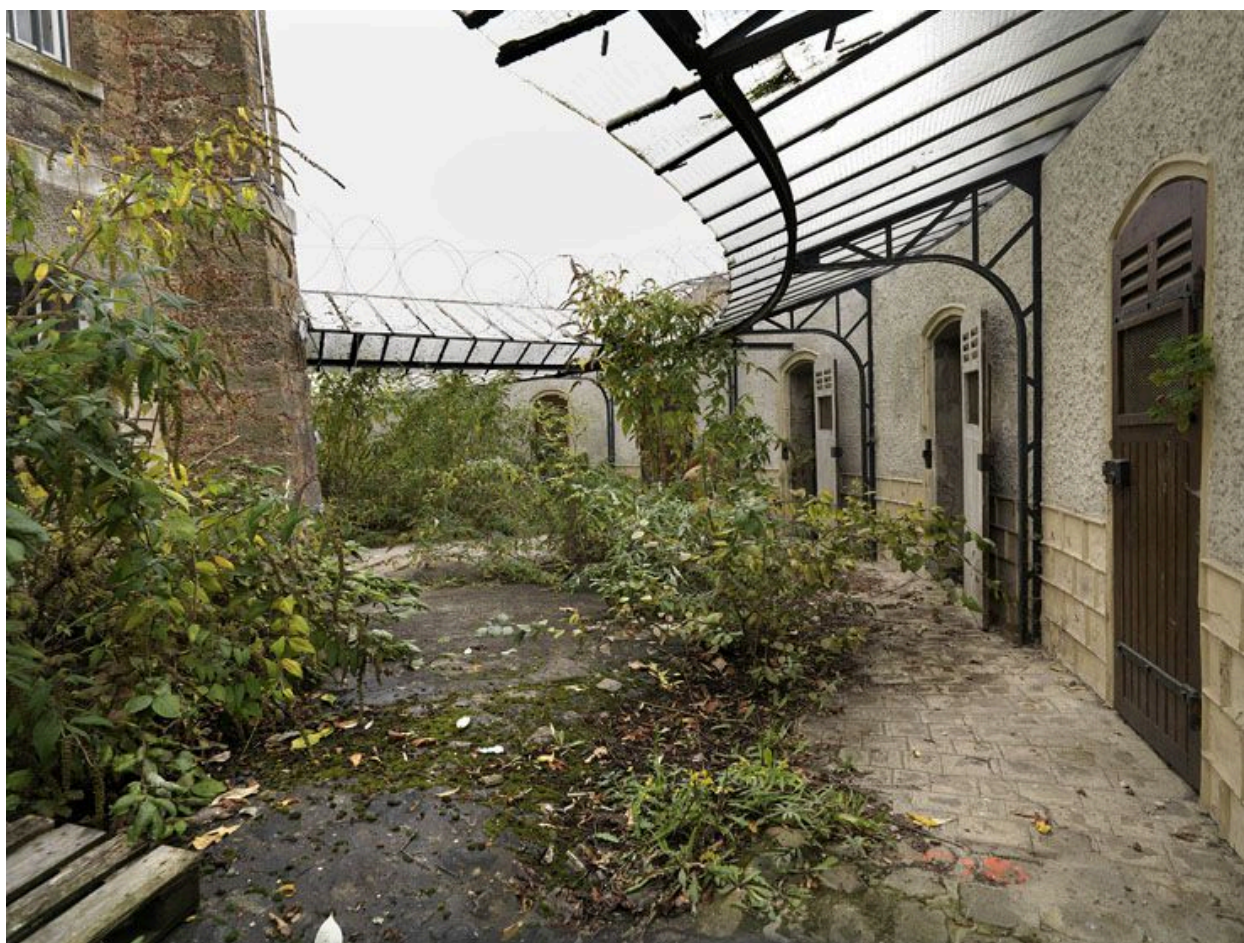
Les portes ouvrant sur les cours de promenade ; vue prise depuis le sud.
