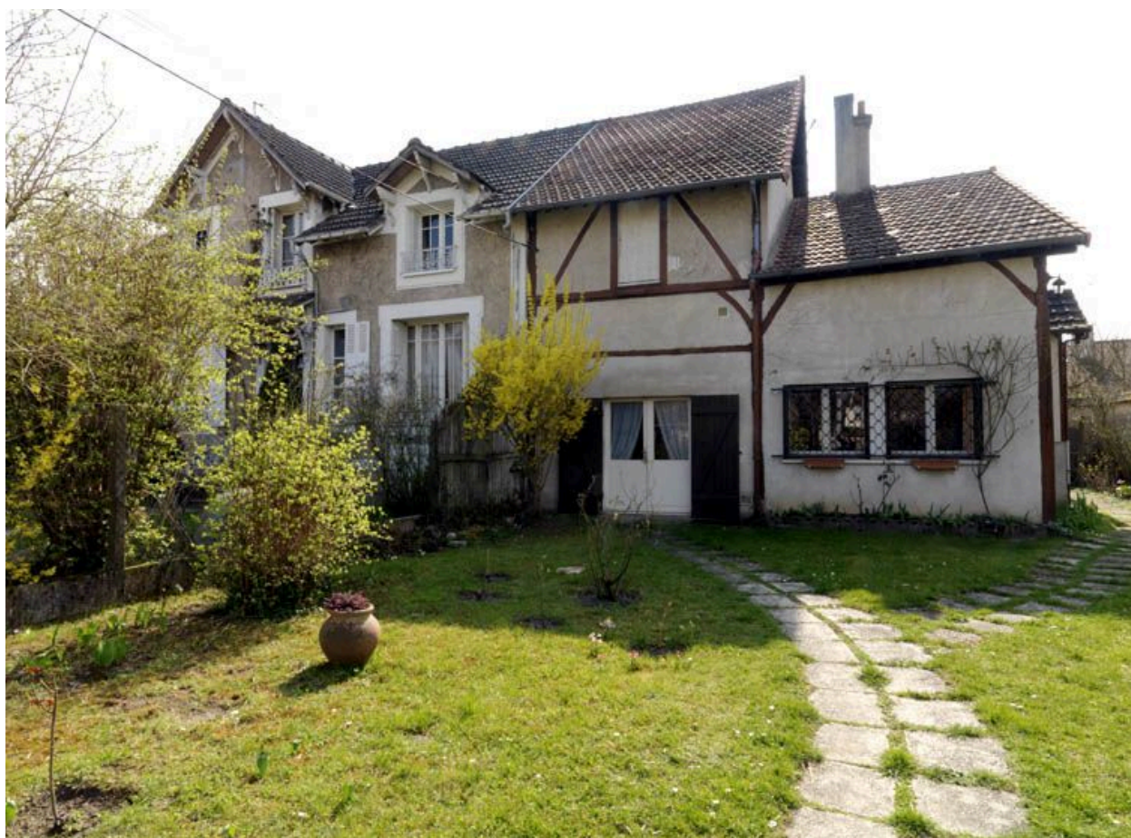
Vue générale de l'atelier du charpentier Canteau.
