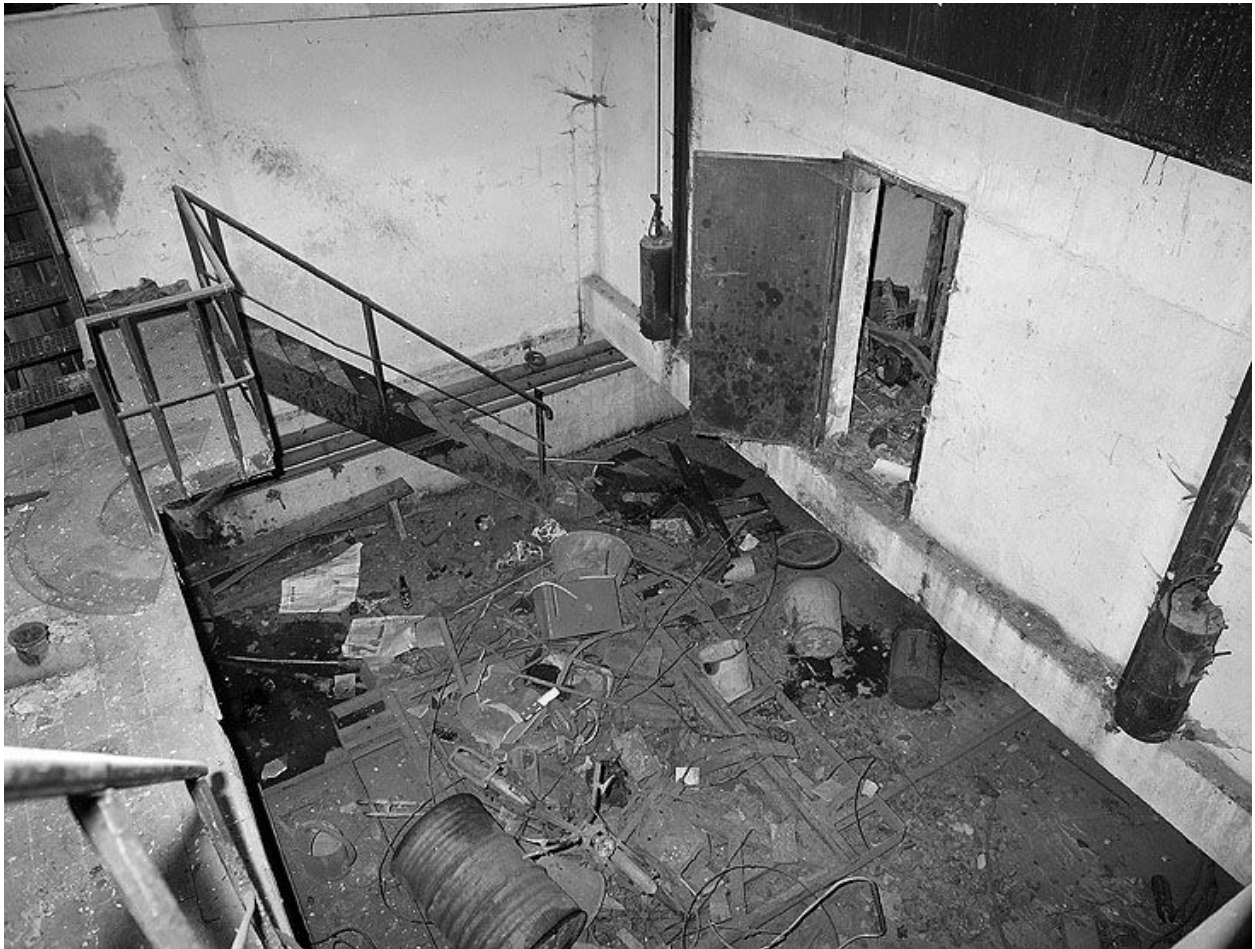
Chaufferie, système d'évacuation des ordures - niveau inférieur. Campagne photographique, lors de la destruction du bâtiment en 1976.
