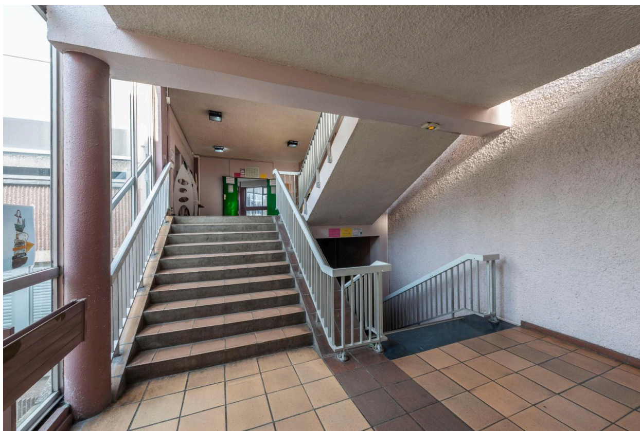
Les escaliers conduisant aux salles de classes.
