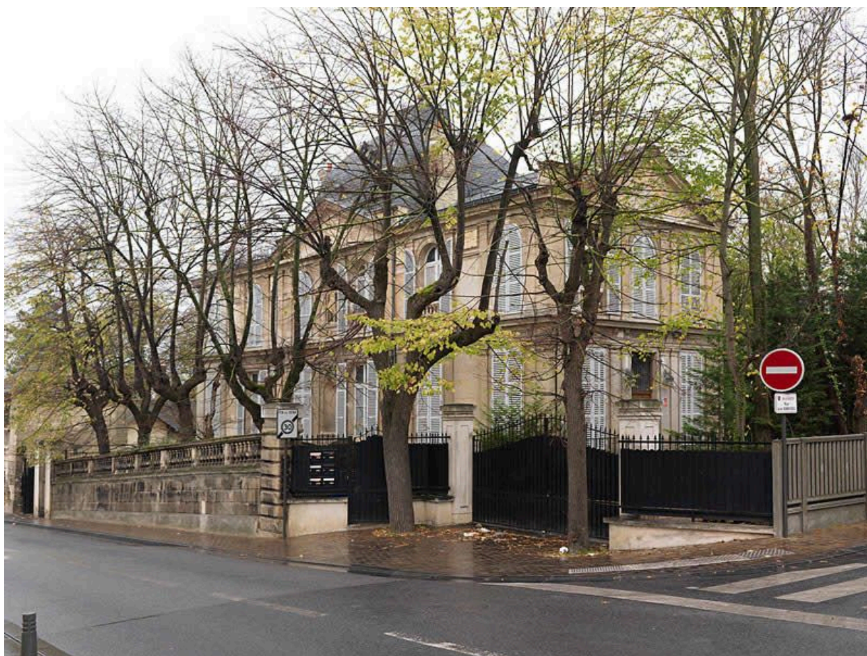
Valenton, maison dite Propriété Noël, 15 rue du Colonel Fabien. Vue d'ensemble.
