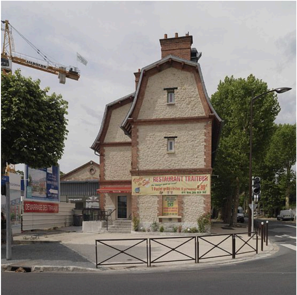
Maison de contremaître, actuellement restaurant et logements.
