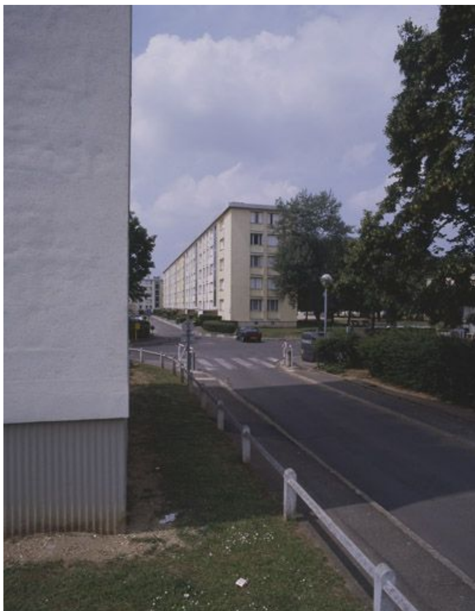
2e tranche du Domaine de Villiers : immeubles le long de la rue Libéral-Bruant.
