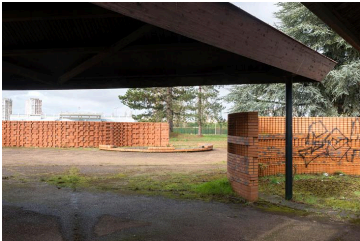
Détail des murs-écrans de forme sinueuse en briques de Vaugirard, réalisés par Charles Gianferrari pour le patio séparant le lycée Saint-Exupéry du lycée Jean Rostand. 1969)
