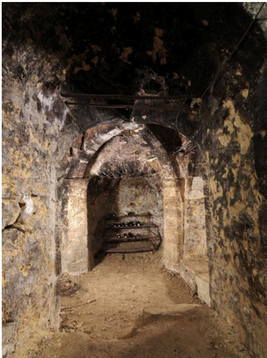
Cave. La salle nord vue depuis le sud.
