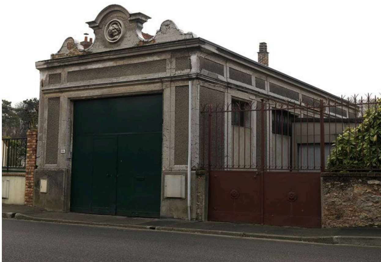
Un ancien atelier, 64 rue Maurice-Berteaux. Vue d'ensemble.
