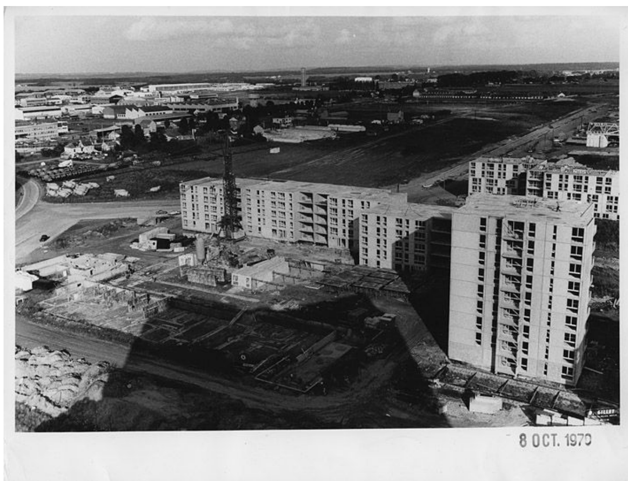
Chantier de la construction de Beauval A et de la ZI vu depuis la tour Albret. 8 octobre 1970. (OPAC Meaux)
