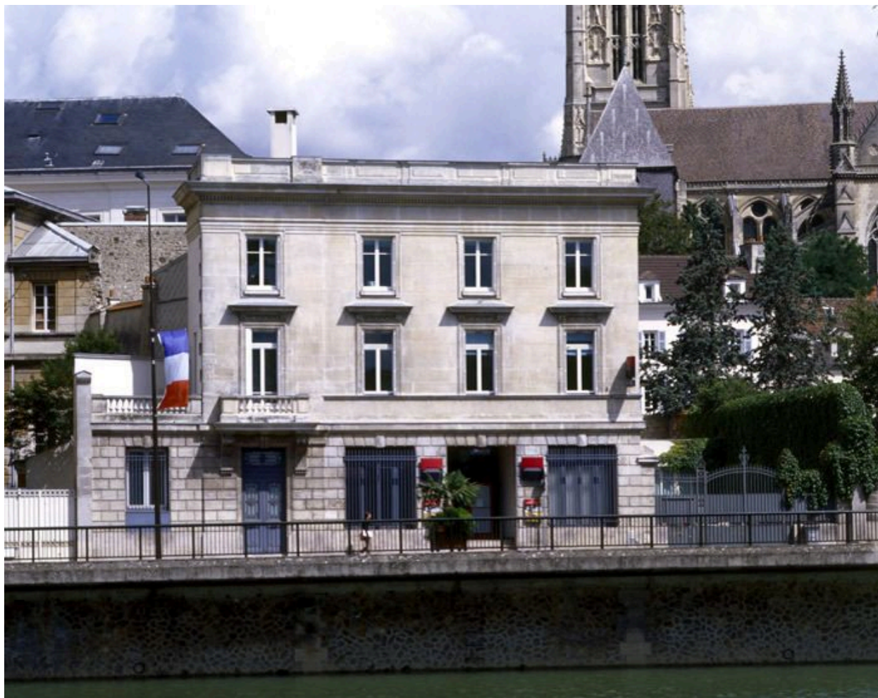
Banque (succursale de la Société générale) sur le quai Victor-Hugo, à proximité de l'hôtel de ville : façade sur la Marne.
