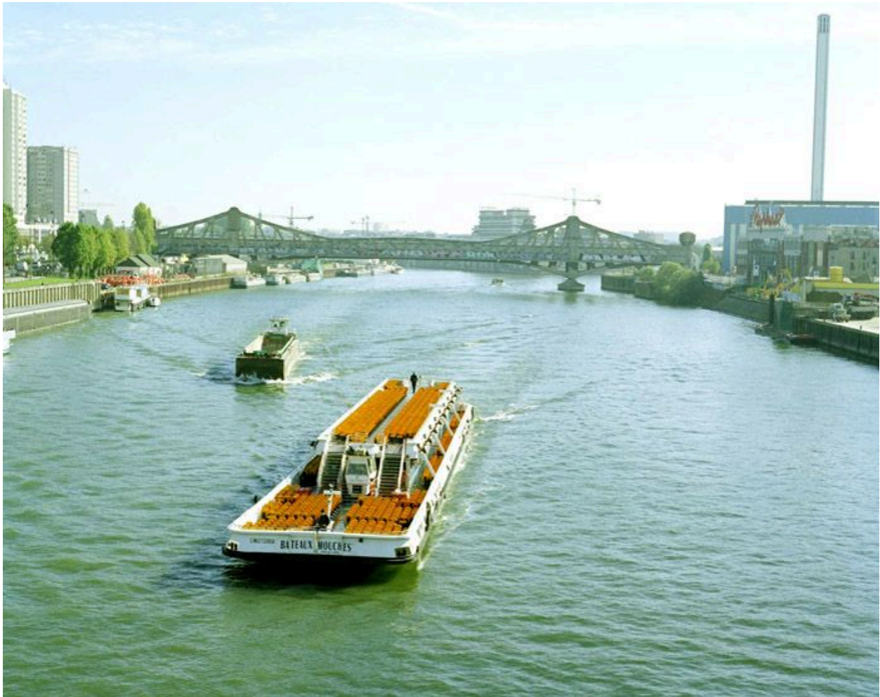
Ivry-sur-Seine, Charenton-le-Pont. Passerelle industrielle d'Ivry-Charenton. La passerelle dans le lointain, au premier plan un bateau mouche.
