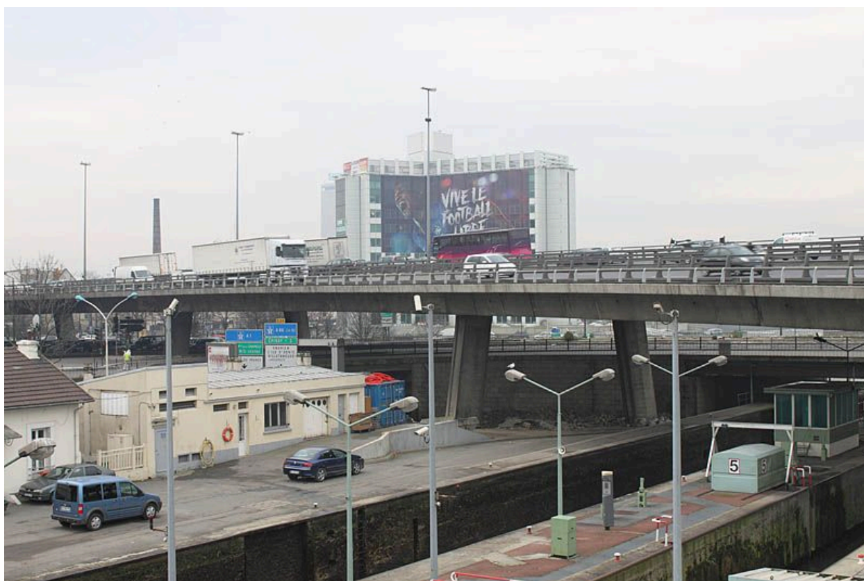
93, Saint-Denis. Viaduc de l'autoroute du nord A1 et de l'écluse de la gare Saint-Denis.
